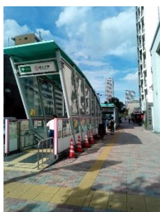
勝どき駅地上出口
